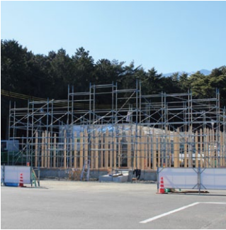
道の駅化に向けて整備を進めています。
