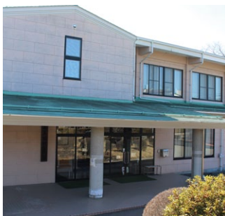
村公民館の耐震工事などを行います。
