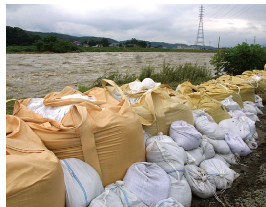
川が氾濫しないよう、土のうをたくさん積んでいます
