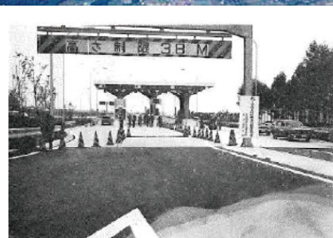
中央自動車道伊那インター入口
