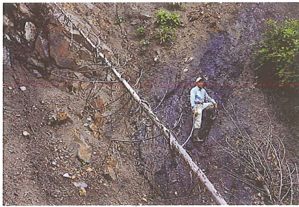
13・8 左写真の破碎帯部分の拡大
