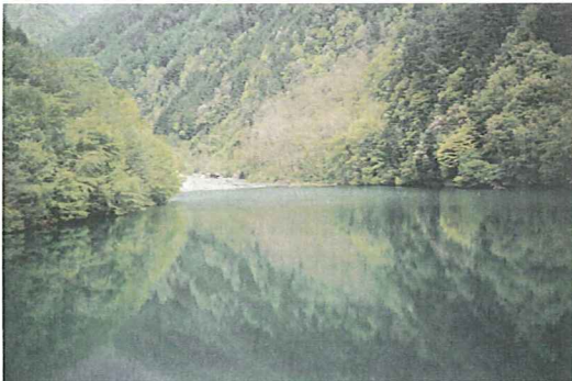
大泉ダムサイト遠望。下 大泉川
