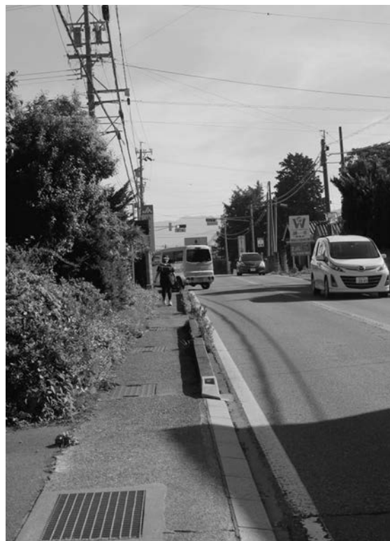
国道153号歩道整備要望箇所
