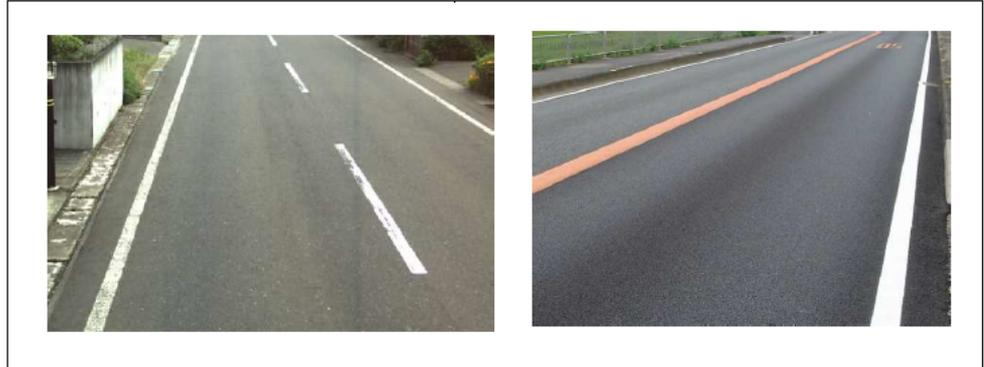
診断区分Ⅱ（表層機能保持段階）：損傷レベル中（IRI = 3～8 mm/m程度）
