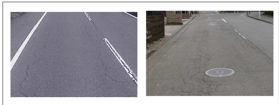
診断区分Ⅲ（修繕段階）：損傷レベル大（ひび割れ率40%程度以上）
