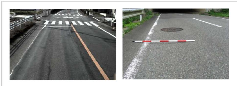
診断区分Ⅲ（修繕段階）：損傷レベル大（わだち掘れ量40mm程度以上）
