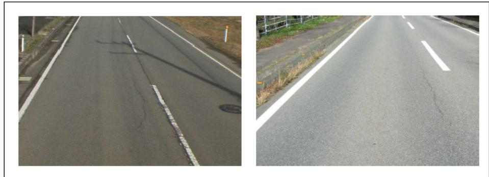
診断区分 II（表層機能保持段階）：損傷レベル中（ひび割れ率 20～40%程度）
