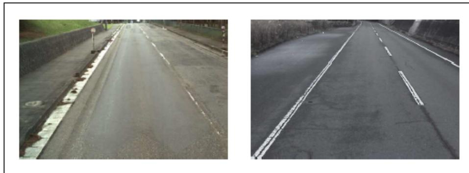
診断区分Ⅲ（修繕段階）：損傷レベル大（IRI = 8 mm/m程度以上）
