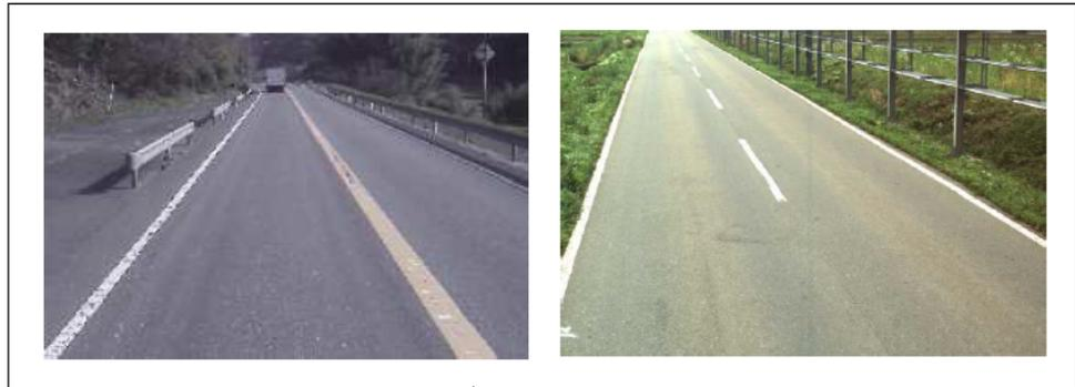
診断区分Ⅱ（表層機能保持段階）：損傷レベル中（わだち掘れ量20～40mm程度）
