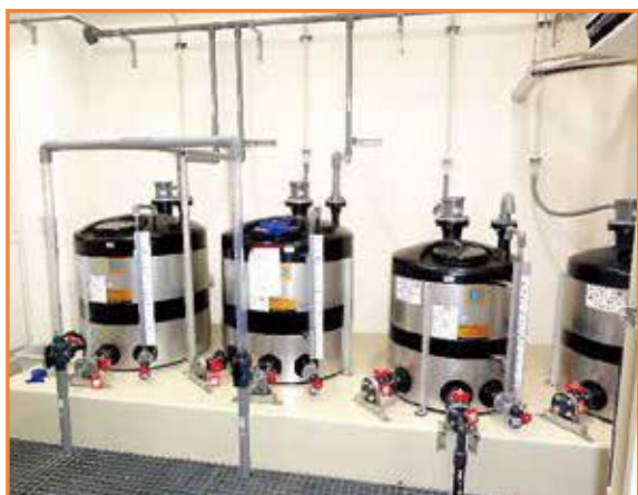
第2配水池薬品貯留槽
