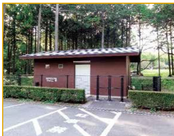
大芝公園内ポンプ場
