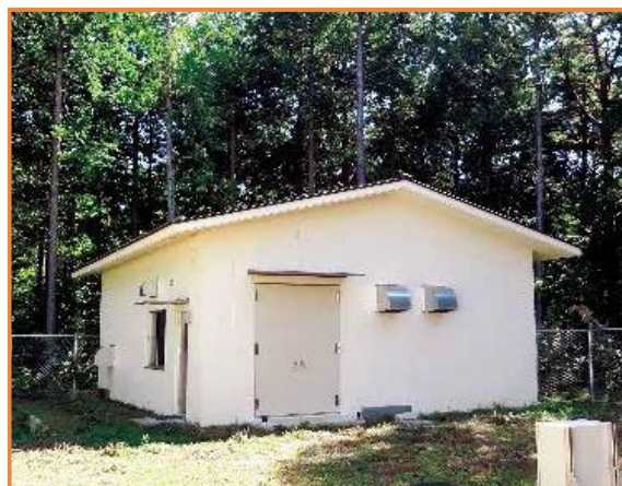
第2配水池薬品室
