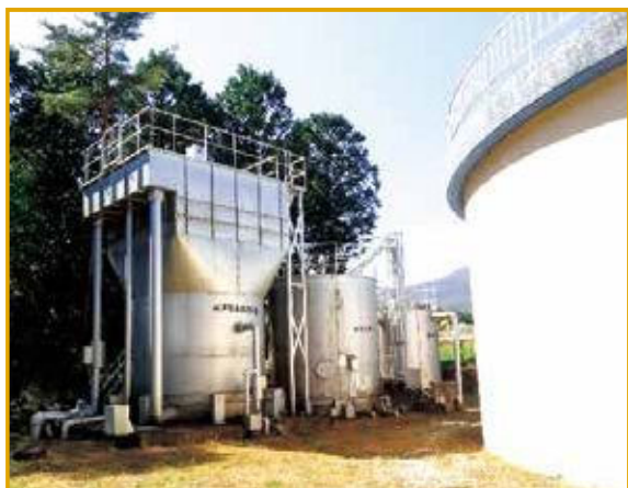
第2配水池及び浄水場
