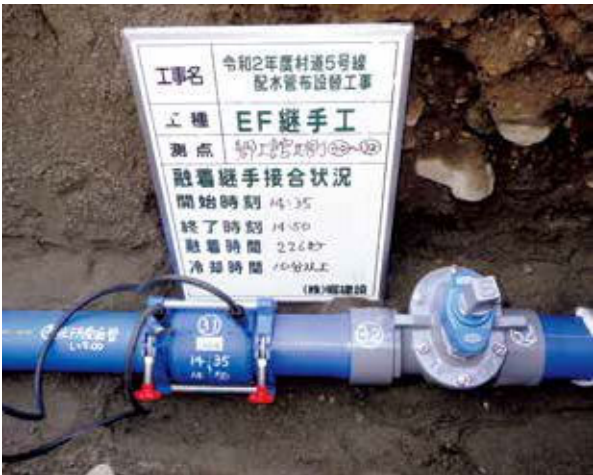
耐震管 水道配水用ポリエチレン管（融着継手）
