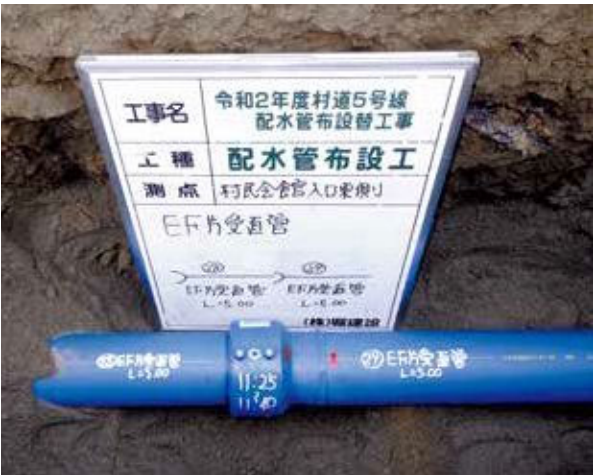
耐震管 水道配水用ポリエチレン管（融着継手）
