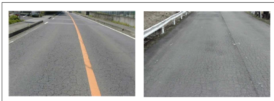
図-6.5 ひび割れ率による診断区分
