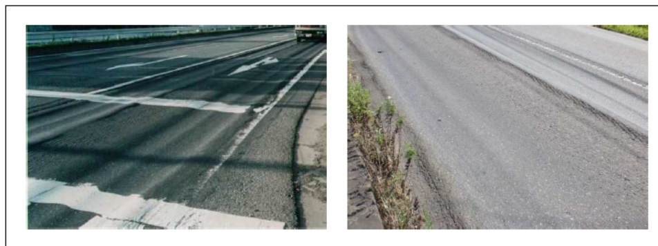
図-6.6 わだち掘れ量による診断区分
