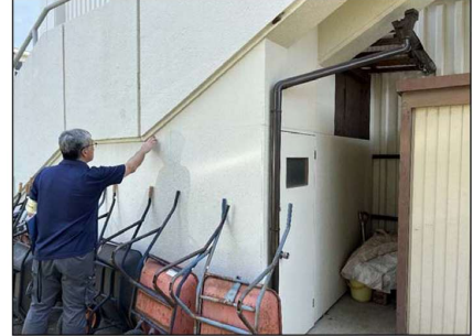
② 増築建物(倉庫)撤去
