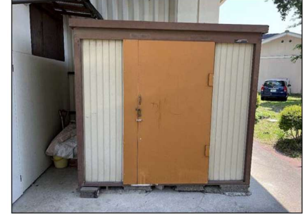
① 増築建物(倉庫)移設
