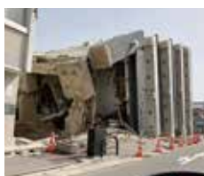
国道沿いのビル横倒れ
