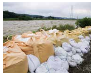
平成18年 土のうの設置の様子
