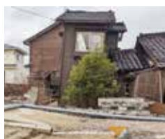
地震道路状況
