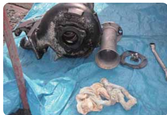
ポンプに詰まっていたタオル
