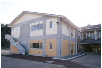
南部小学校教室棟
