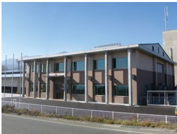
伊那消防署新庁舎
