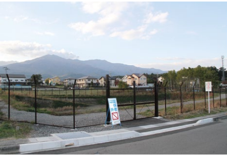
南原雨水配水処理場
