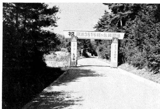
図5-32 林道経ヶ岳→国道361号線全線舗装完成開通
