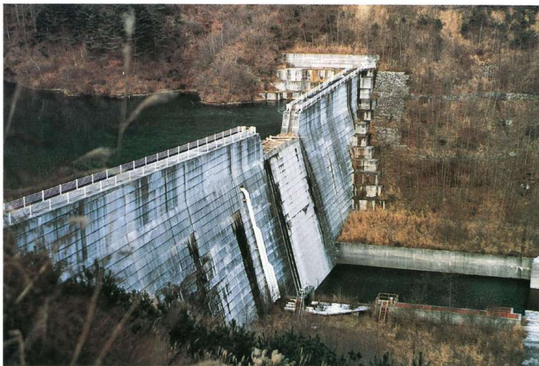
大泉川砂防ダム
